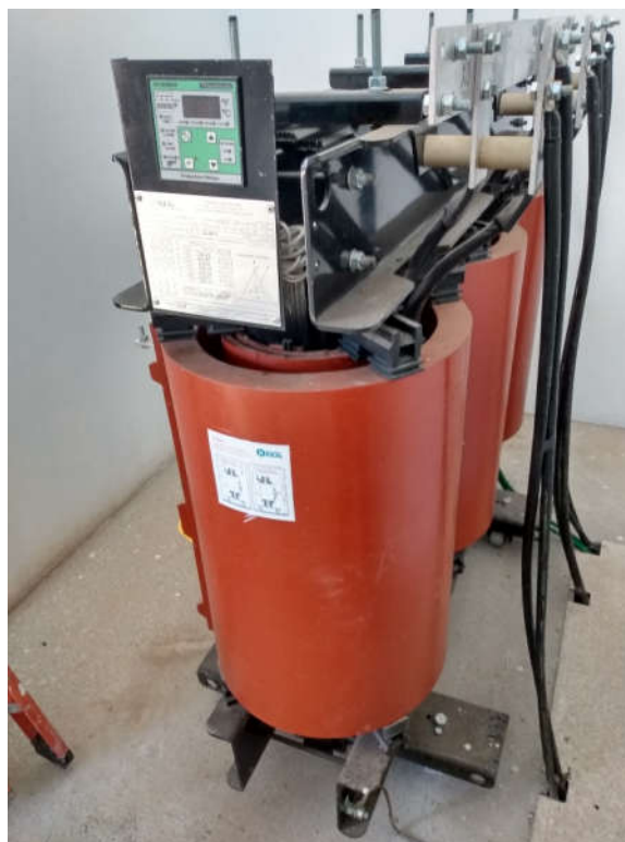
Imagem11- Transformador Trifásico 500 KVA 13.800V/440V à seco da usina solar.
