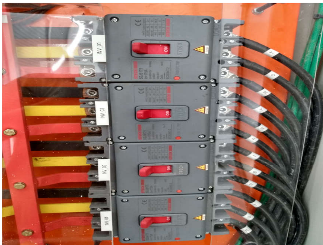
Imagem07- Disjuntor Geral do QGBT do cubículo do transformador da usina solar.
